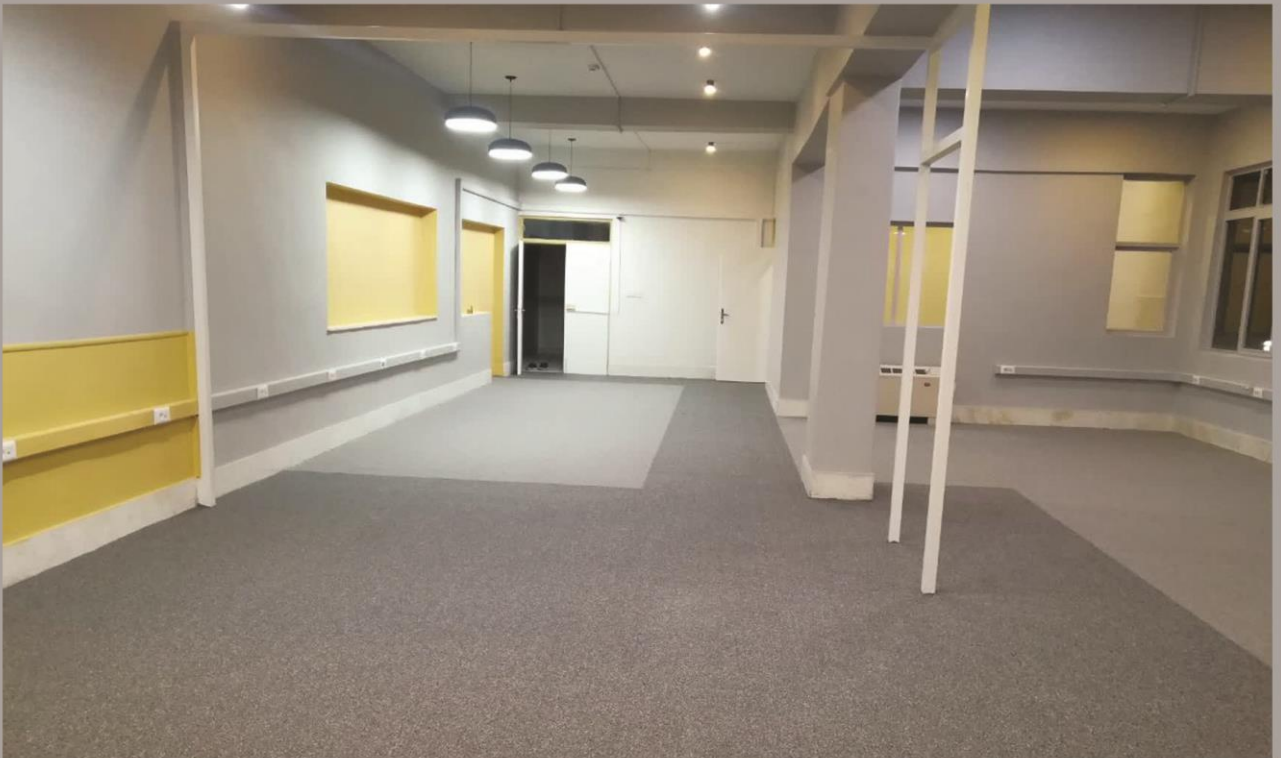
بازطراحی و تغییر کاربری آزمایشگاه برق و الکترونیک به شتابدهنده در دانشگاه علم و صنعت ایران وضعیت: در حال اجرا
