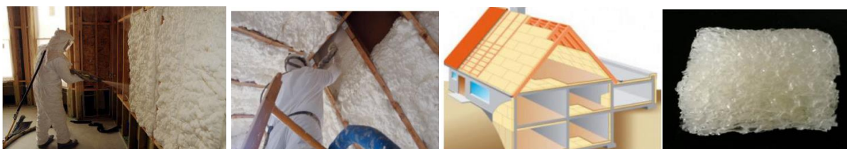
شکل (۲-۱۲): انواع مدل و کاربرد فوم پلی یورتان [۱۱]
