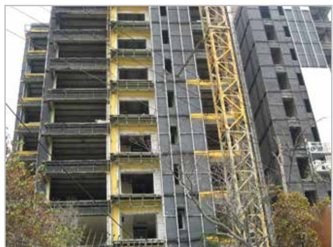
◀ پروژه خیابان دزاشیب
