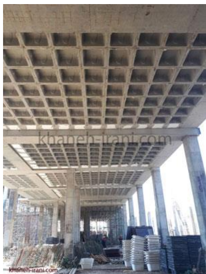
نمونه سقف اجرا شده با قالب وافل دو طرفه
