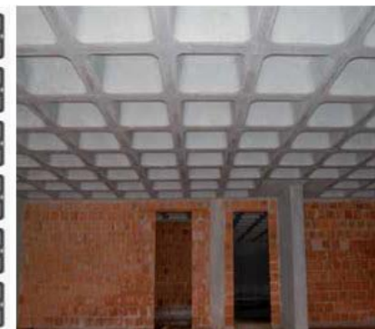
سقف وافل اجرا شده و نحوه چینش قالب‌های وافل و طرفه در سقف
