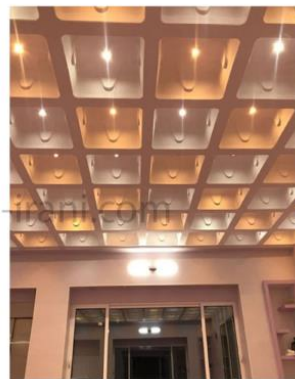
سقف وافل دو طرفه اجرا شده بدون سقف کاذب با نمای رنگ و نورپردازی شده
