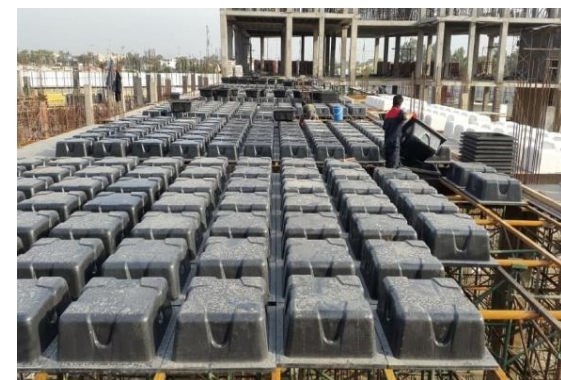
چینش سریع و ساده قالب وافل دو طرفه
