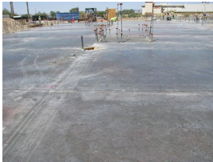
شکل ۵- استفاده از الیاف ماکرو مصنوعی به منظور کنترل ترک‌های حرارتی و جمع‌شدگی در پروژه‌ی دادگاه فدرال یوما
