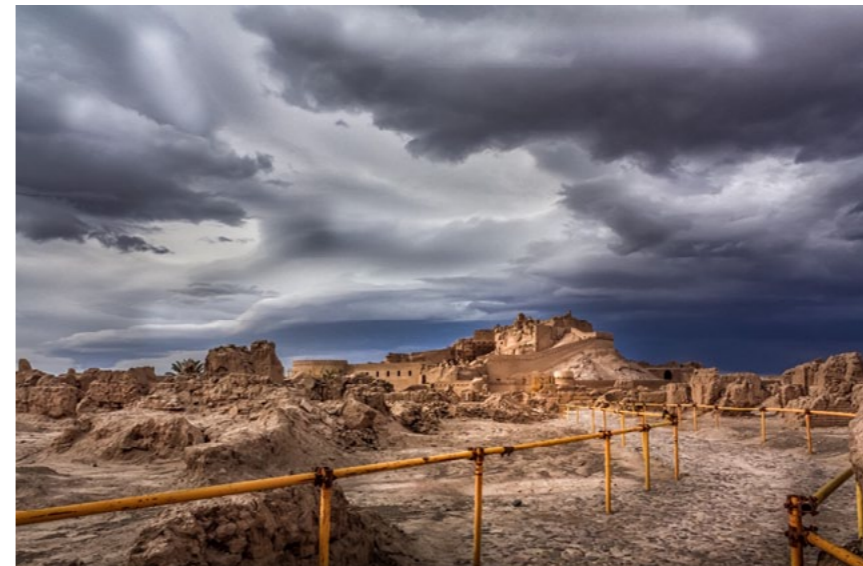
شکل ۱: ارگ بم پس از زلزله‌ی سال ۸۲
