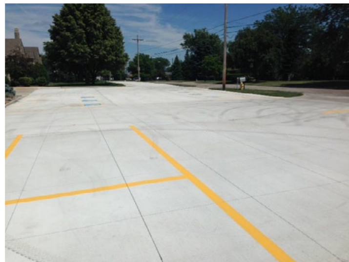
شکل ۴- استفاده از الیاف ماکرو مصنوعی به جای میل‌گردهای حرارتی در پروژه‌ی دانشگاه ایالت اوهایو
