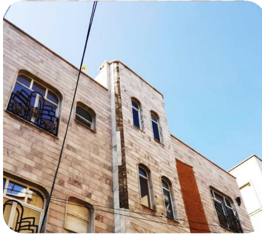
نمونه‌ای از جدا شدن سنگ نما در اثر عدم گیرش مناسب
