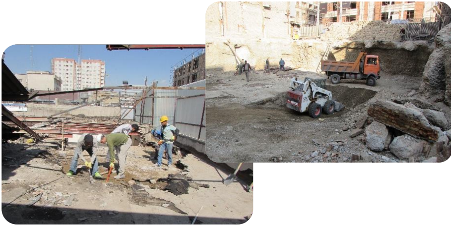
تخریب، گودبرداری و تسطیح محوطه
