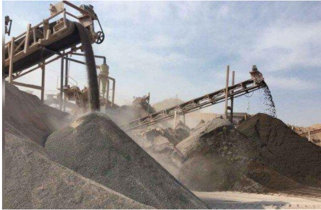
انبار و جداسازی مصالح سنگی از یکدیگر
