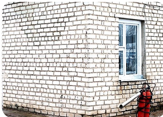
اجرای دیوار با آجر ماسه آهکی
