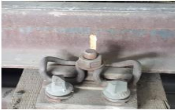
شکل 21. چفت و بست مربوط به ریل قطار شهری مشهد.
