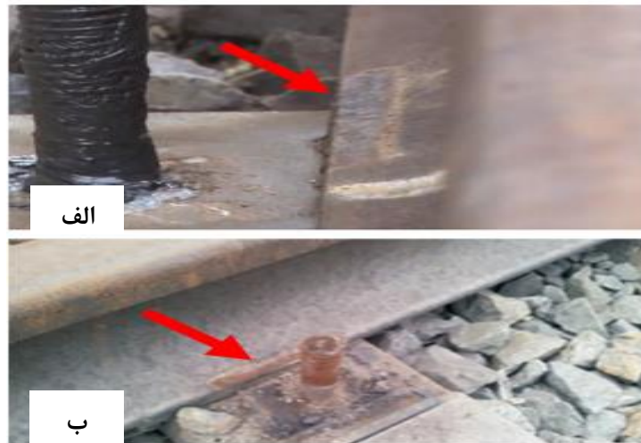
شکل 4. خوردگی شیاری پس از حذف نوار الاستیک [8].
