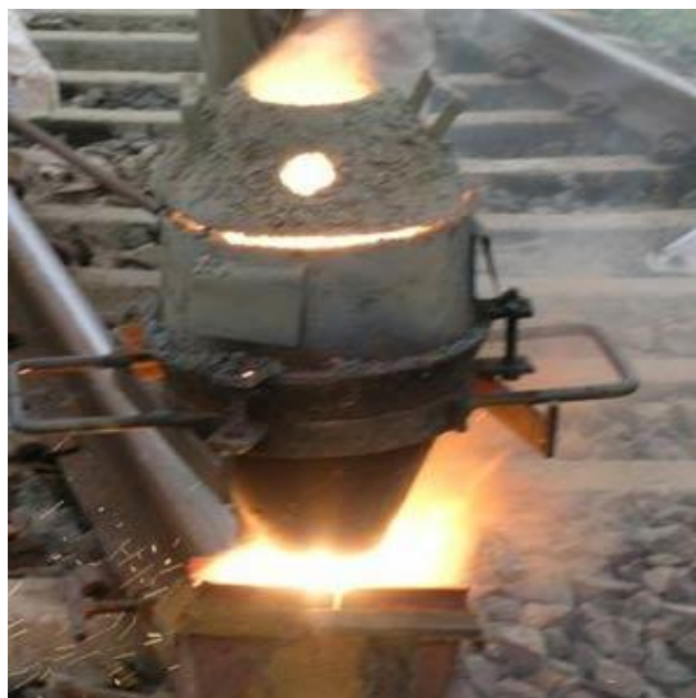
شکل 8. جوشکاری ریل به روش ترمیت.
