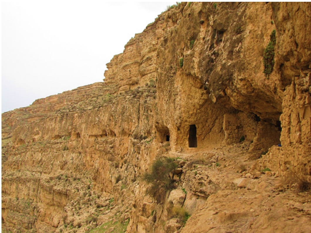
تصویر ۱۱: نمایی از ساخت و سازها و راهروهای دستکند که غارهای تادوان را به هم متصل می‌کنند.
