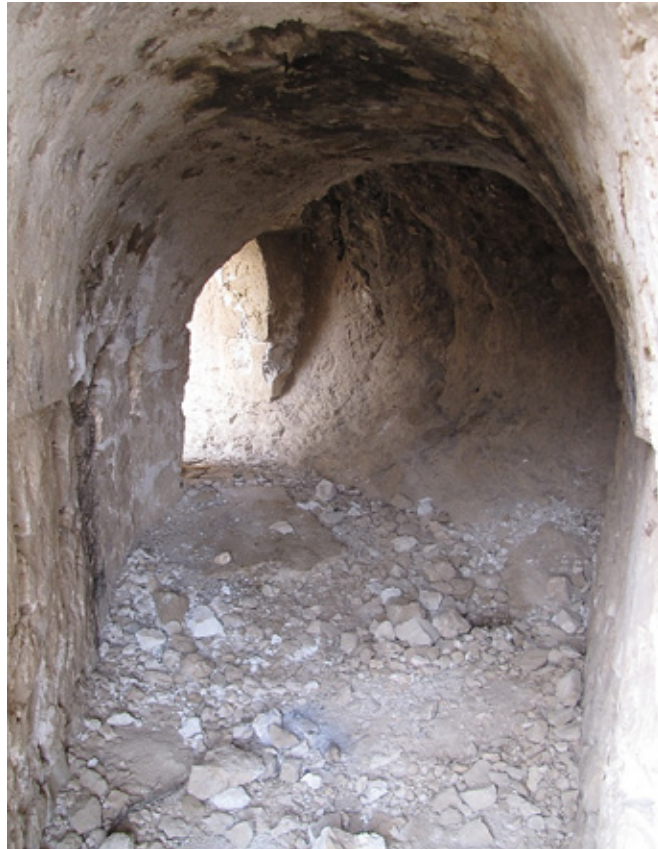
تصویر ۱۴: نمایی از راهروهای تلفیقی از معماری دستکند و طاق آهنگ از مصالح سنگ و ساروج.
