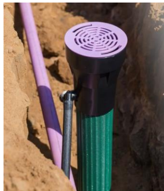
شکل ۳- نصب آسان سیستم RZWS
