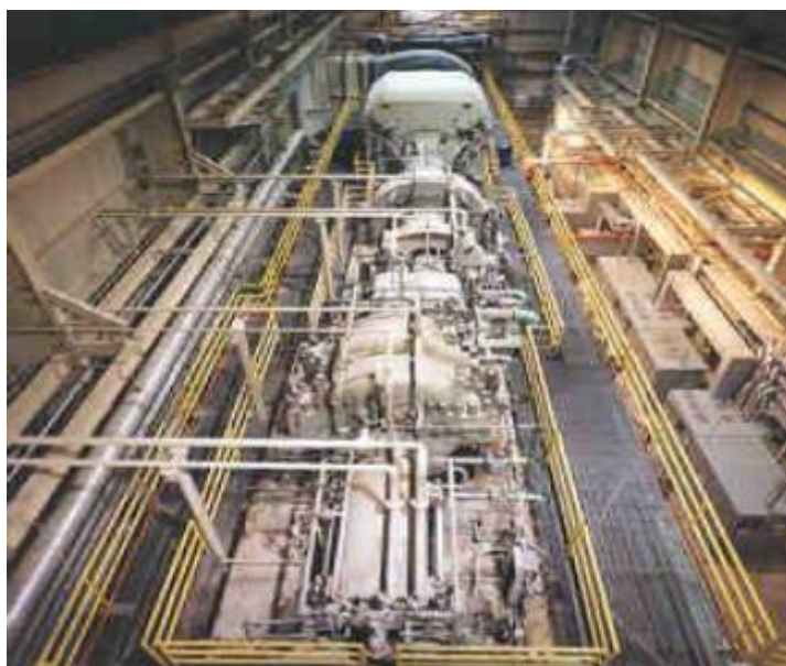
شکل ۴-۵ تصویر واقعی موتور-ژنراتور و مجموعه کمپرسورهای نیروگاه آلاباما
