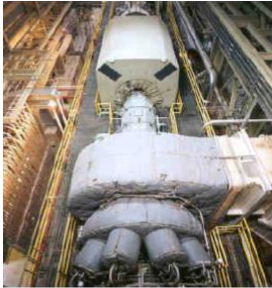
شکل ۴-۶ تصویر واقعی از اکسپندر فشار قوی نیروگاه آلاباما
