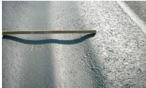
شکل ۱. خرابی شیارشدگی
