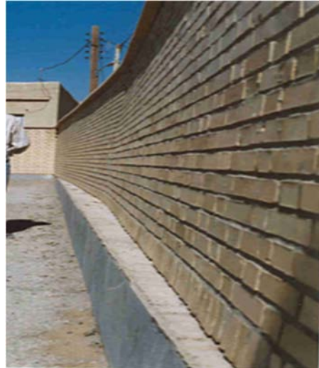
شکل (۴): عدم کنترل طول آزاد.
