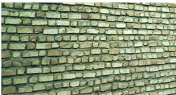
شکل (۳): خالی بودن درزهای قائم بین واحدهای بنایی از ملات.
