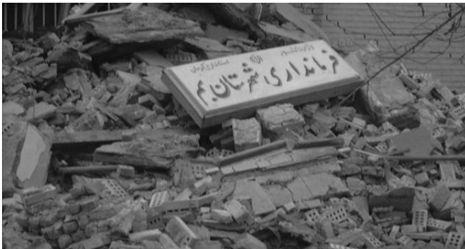
فرمانداری شهرستان بزم که در زلزله بزم به طور کامل تخریب گردید.
